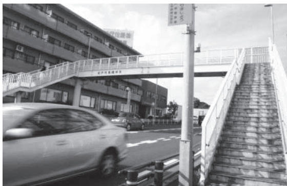
信号と横断歩道が設置される馬橋弁天歩道橋
